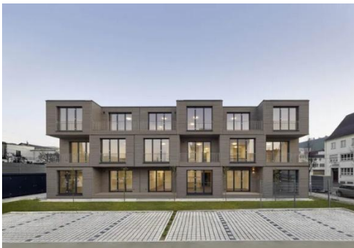
Wohnanlage für Klinikpersonal Esslingen Planungs- und Bauzeit 2018-2019
