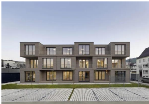
Wohnanlage für Klinikpersonal Esslingen Planungs- und Bauzeit 2018-2019
